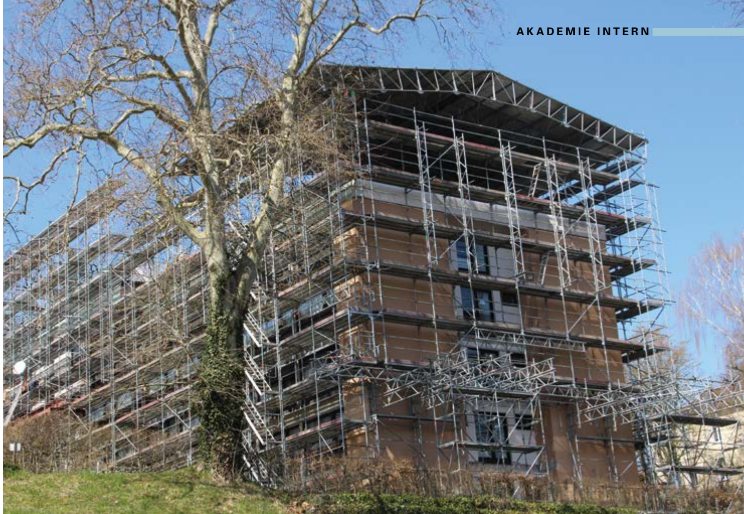
Aufbau des Wetterschutzdaches für die Sanierung des Gästehauses der Akademie (2020).
