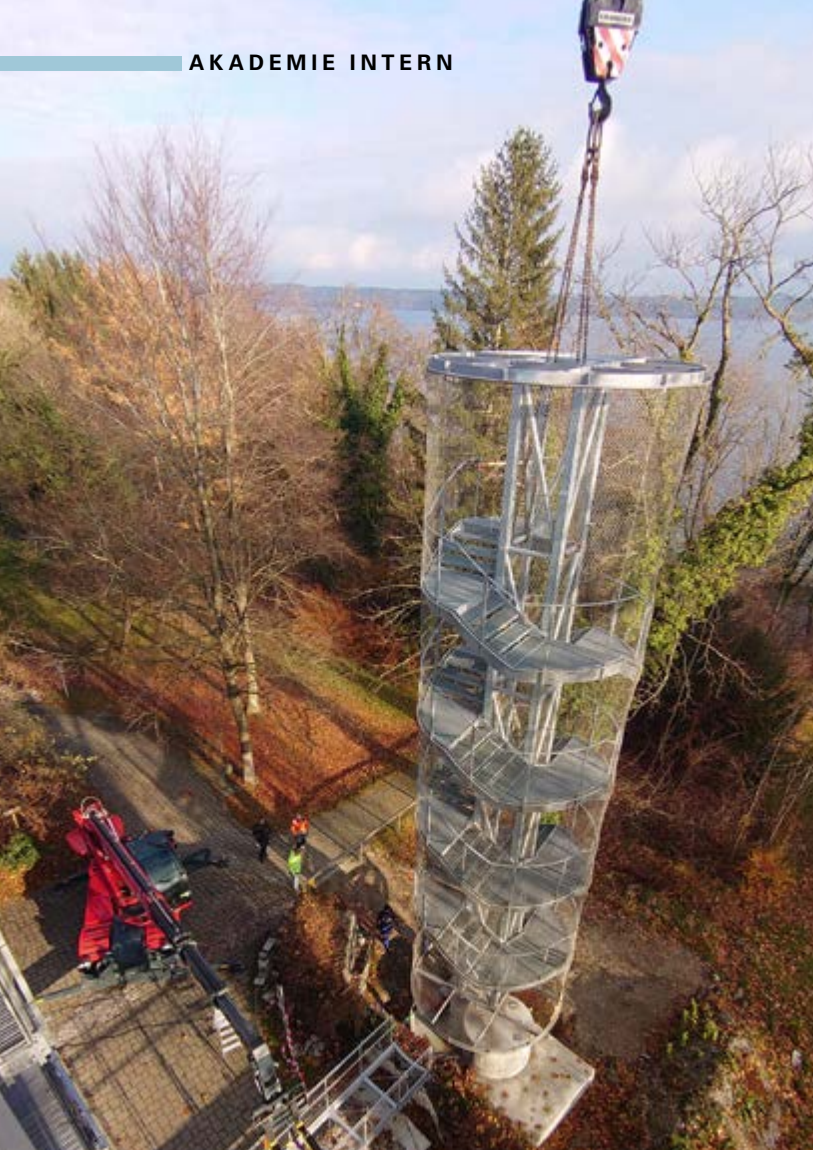
Zentimeterweise schwebt der neue Fluchtturm seinem massiven Sockelfundament entgegen – herbstlicher Blick vom frisch sanierten Dach des Gästehauses der Akademie (2022). Fotos: APB
