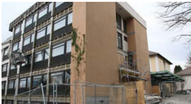
Entfernung der verwitterten Balkone und Fensterelemente des Gästehauses (2020).
