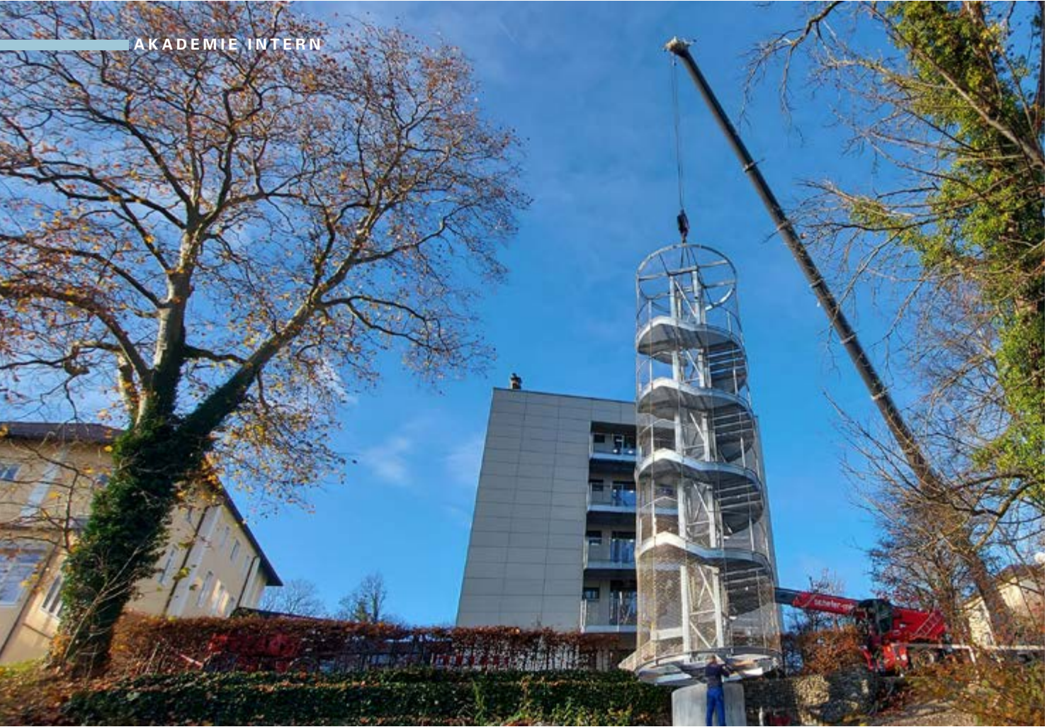
Spektakuläre Montage des neuen, seeseitigen Fluchttreppenturms für das komplett energetisch sanierte Gästehaus der Akademie (2022).
