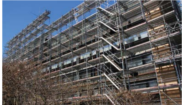
Die energetische Sanierung des Gästehauses reduziert bis März 2021 die Zahl der Zimmer. © Schröder (APB)
