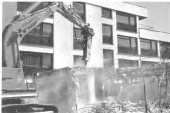
Der Presslufthammer kriegt Stahl und Beton klein. Fotos: Schröder
